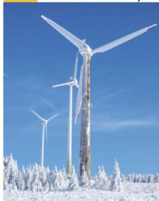
La formation de givre entraîne l'arrêt d'une éolienne. Une peinture antigivre conductrice de courant électrique permet de dégivrer l'éolienne par l'effet Joule.
